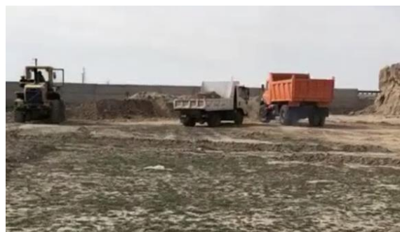
شکل ۳- بولدزور مشغول کار و کمپرسی‌ها در حال بردن خاک
