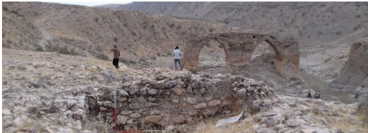
تصویر ۱۳. نمای از بنای ضلع شمال شرقی پل سی‌پله که در پس زمینه آن پل سی‌پل نیز دیده می‌شود
