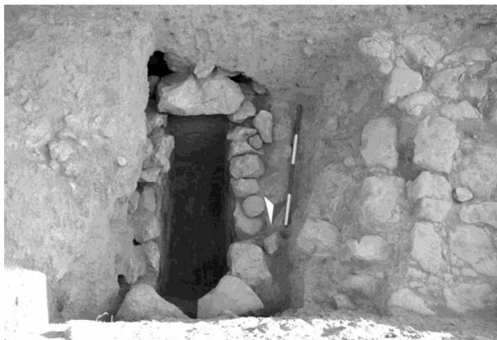
شکل ۴: استخر - فاز دو - مجرای فاضلاب در زیر خیابان سنگفرش شده (ل. ابانیستا).
