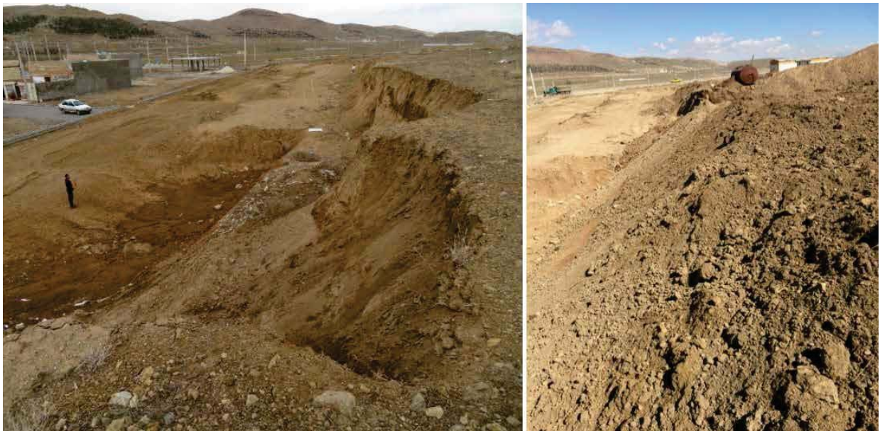
تصویر ۵. وضعیت تخریب بخشی از کوی کیوان در تصویر اسفند ۱۳۹۷ و خرداد ۱۳۹۸
