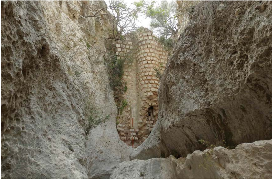
تصویر ۶. نمایی از سد دوگلی (دید از شمال)
