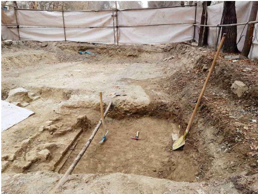
تصویر ۵. کفسازی خیابان چهارباغ در کارگاه ۵
