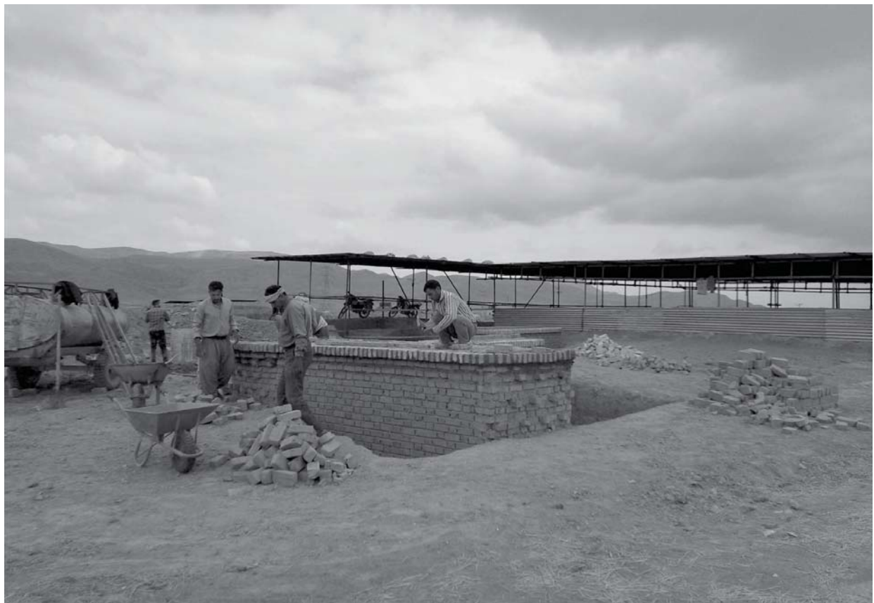
تصویر ۸. تصویری از روند مرمت و اجرای سقف پوششی در گمانه F16.1
