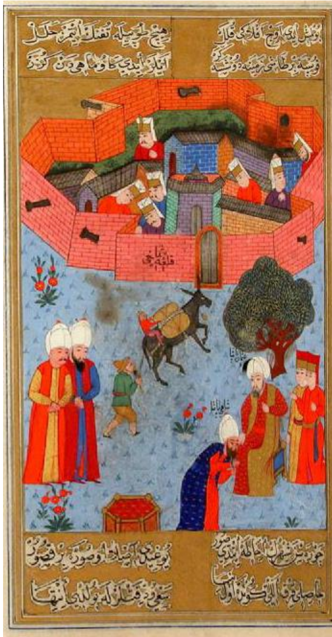
بنا و احداث قلعه شماخی توسط عثمان پاشا
