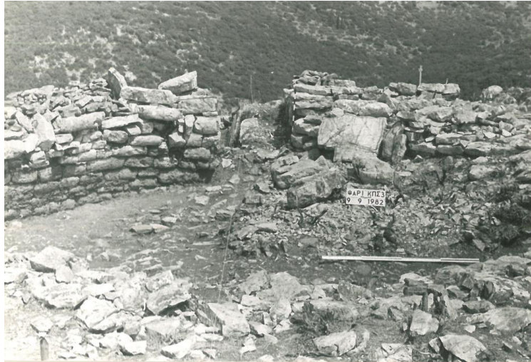
Εικ. 4. Άποψη εισόδου θολωτού από Ν.
