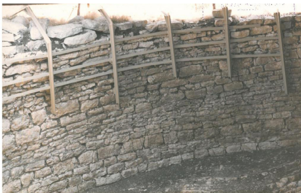
Εικ. 9. Τοιχοποιία θαλάμου και αγκυρώσεις.
