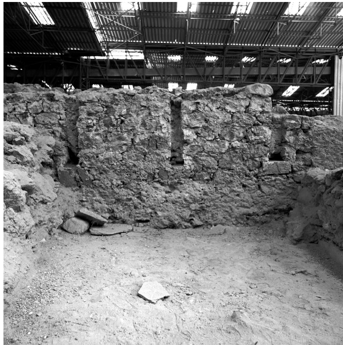
Εικ. 9. Ακρωτήρι Θήρας. Τα αρνητικά αποτυπώματα ξυλοδεσιάς στον νότιο τοίχο της Ξεστής 3.
