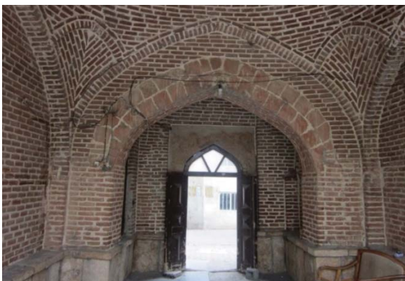
تصویر ۱۷. تزئینات آجرکاری جناغی هشتی ورودی مسجد جامع مهاباد
