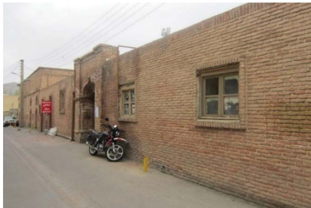
تصویر ۵. نمای ضلع جنوبی مسجد جامع مه‌آباد.
