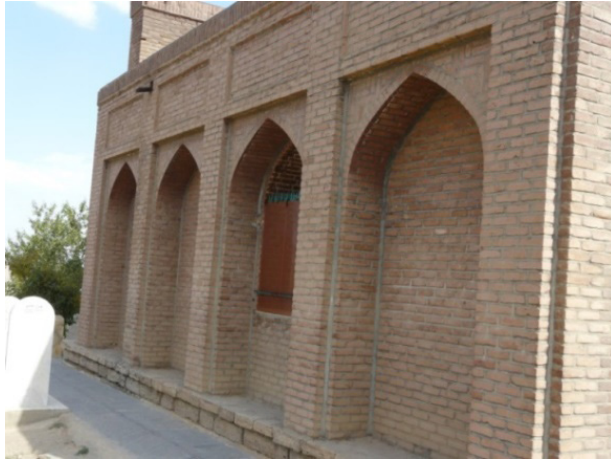
تصویر ۱۲. تاق‌نماهای نمای شمال غربی مقبره شیخ شمس براهانی
