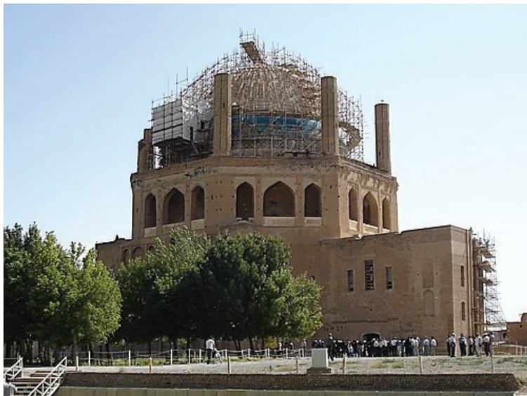
تصویر امروزی گنبد سلطانیه در حال کاشی‌کاری گنبد (حمزه‌لو، ۱۳۸۱: ۱۰۵)
