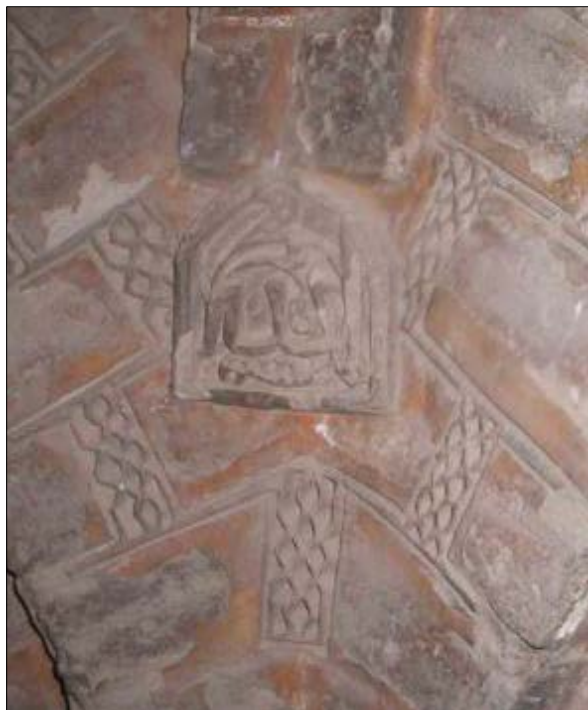
تصویر ۸. تزئینات داخلی که با گچ ایجاد شده است
