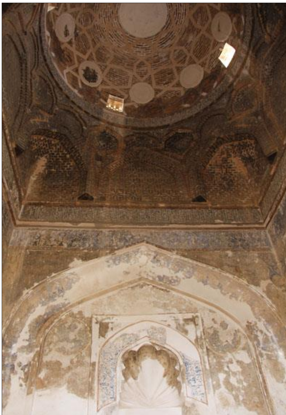
تصویر ۲۶. نمایی از فضای زیر گنبد و کتیبه‌ها و تزئینات اطراف محراب صدفی مسجد
