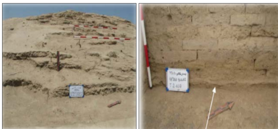
تصویر ۲. اندود جداره بیرونی دیوار و قسمتی از خشت‌ها و شفته، تصویر ۳. برج نیم‌دایره در قسمت جنوبی دیوار ارگ
