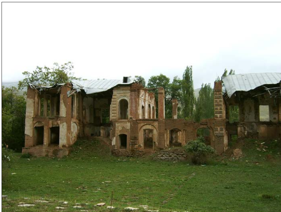
تصویر ۹. نمایی از عمارت نیمه ویران قلعه جوق ماکو مشابه با ساختمان بانک ملی (مرکز اسناد و مدارک میراث فرهنگی آذربایجان غربی)
