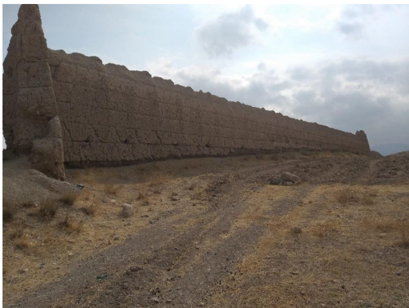
۱۱. نمای خارجی ضلع غربی کاروانسرا
